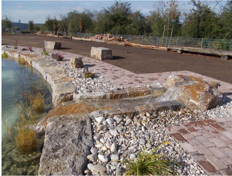
Foto Nr. 3.: Blick über den neu geschaffenen Teich mit dem sprudelnden Einlauf des Wassers. Was zunächst vielleicht etwas steril wirkt, bietet Vögeln den Zugang zum Wasser ohne größere Versteckmöglichkeiten für lauernde Katzen, die in jedem Vorgarten solche Wasserquellen gleich wieder entwerten – der Vorteil, wenn man Platz hat. Die Wiese im Bild rechts muss erst noch aufwachsen, Altgrassäume entwickelt werden. (Foto: Auftraggeber).
