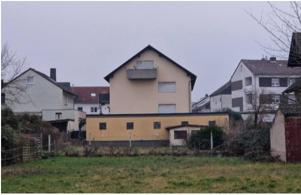
Rückwärtige Ansicht Plangrundstück
