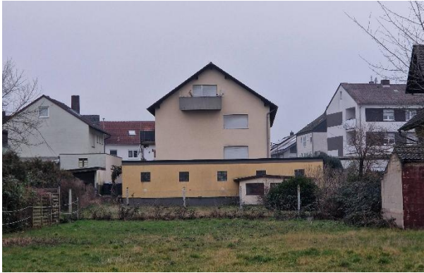
Rückwärtige Ansicht Plangrundstück
