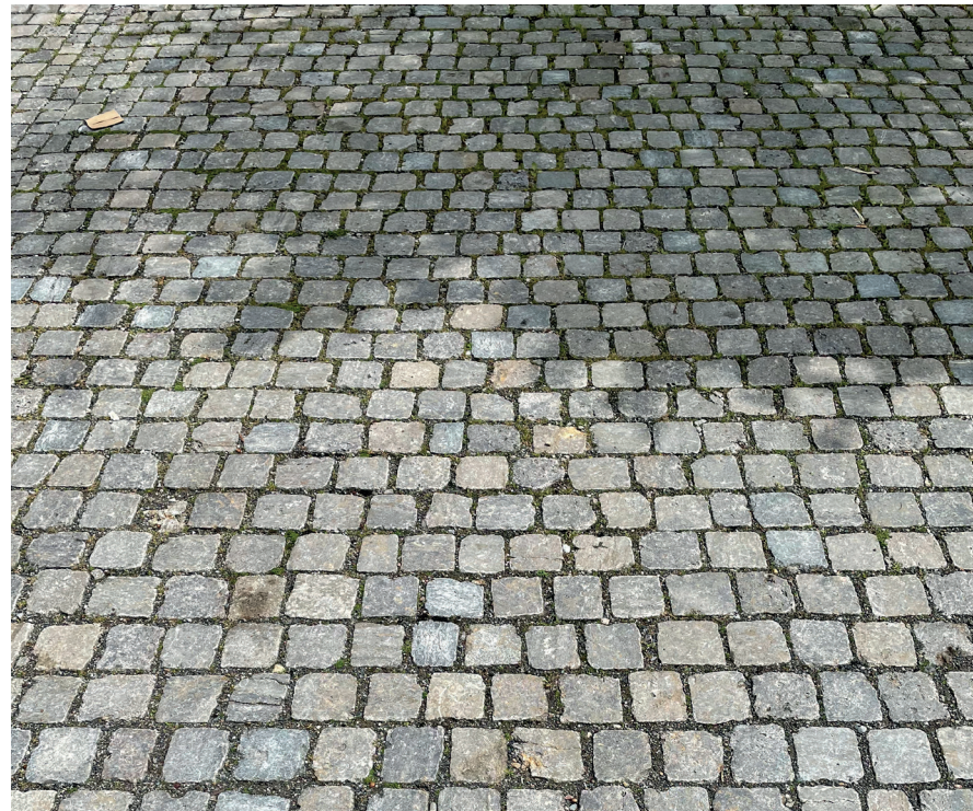
Material Platz: helles Naturstein-Kleinpflaster in Reihe verlegt
